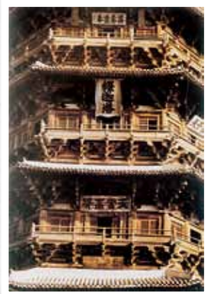
山西應縣佛宮寺釋迦塔局部。
